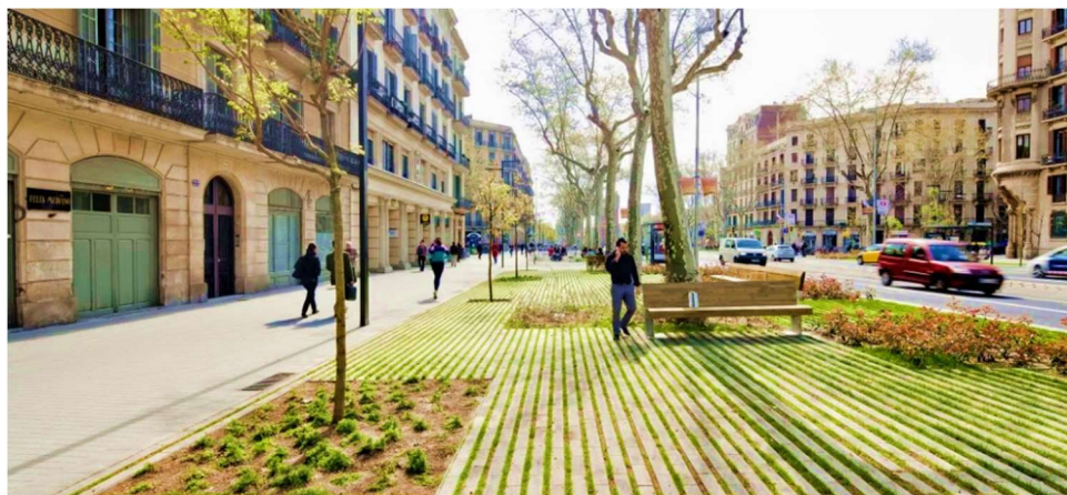
Il. 14. Wielofunkcyjny bulwar St. Joan w Barcelonie na fragmencie ulicy powstałej w ramach planu urbanistycznego Ildefonsa Cerdà z 1859 r. (proj. Lola Domènech, 2008-2009), fot. Adrià Goula, (fotografia udostępniona dzięki uprzejmości autora).
