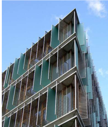
Il. 17. Bardzo popularna w ostatnich latach elewacja budynku z ruchomymi okiennicami, które wpuszczają energię słońca do wnętrza lub zatrzymują ciepło – tutaj w budynku Szkoły Biznesu w Kopenhadze, fot. G. Schneider-Skalska.
