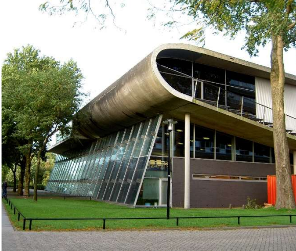
Il. 16. Duże przeszklenia elewacji budynków od strony południowej pozwalają dogrzać wnętrze w naturalny sposób, sprzyjają zmniejszeniu zużycia energii ze źródeł nieodnawialnych; wysunięty okap i drzewa liściaste chronią przed przegrzaniem, a w zimie utrata liści zwiększa dostęp słońca do wnętrza (Utrecht), fot. G. Schneider-Skalska.
