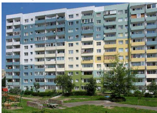
Il. 5. Budynek z wielkiej płyty typu WBS 70 (Wohnungsbauserie 1970) w Halle w dzielnicy Silberhöhe, źródło: https://pl.wikipedia.org/wiki/Wielka_p%C5%82yta#/media/Plik:CN_HALLE_20170408_113724_TL.jpg , (data dostępu: 5.03.2020).
