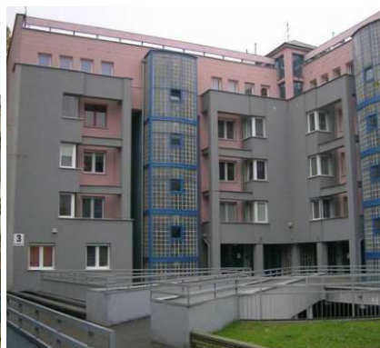
Il. 16. Postmodernistyczne osiedle mieszkaniowe Centrum E, Nowa Huta, Kraków, źródło: https://mapio.net/pic/p-5790338/ , (data dostępu 12.01.2020).
