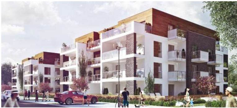
Il. 28. Zabudowa wielorodzinna - punktowce, Rzeszów, proj. Urban Project, sp. z o.o. Źródło: Urban Project, sp. z o.o.
