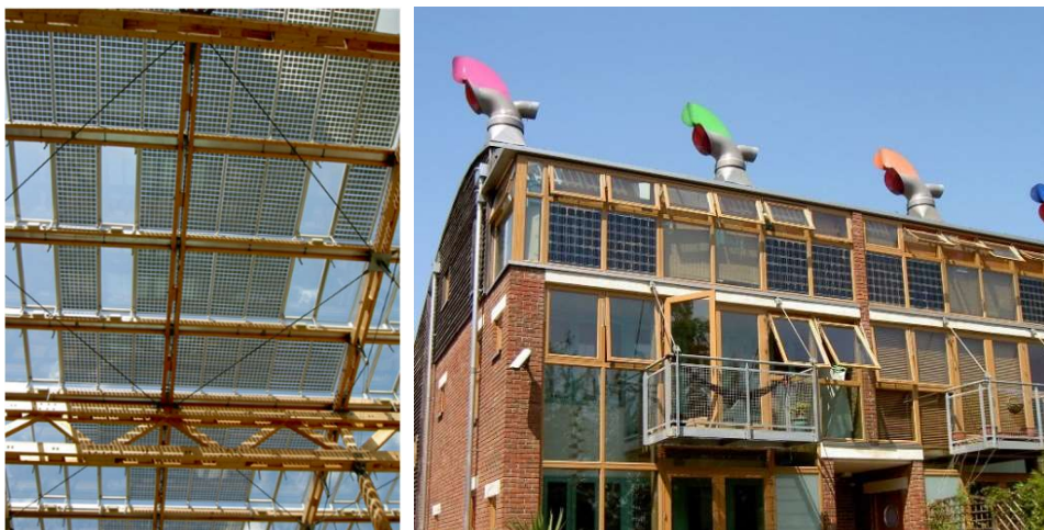
Il. 18 - 19. Ogniwia fotowoltaiczne na dachu w budynku Akademii Mont Cenis w Herne (Niemcy, z lewej) oraz na przeszkleciu werand w zespole mieszkaniowym BedZED pod Londynem (z prawej). Ogniwia przetwarzają energię słoneczną na energię elektryczną jednocześnie zaciemniając wnętrze chroniąc przed przegrzaniem, fot. G. Schneider-Skalska.
